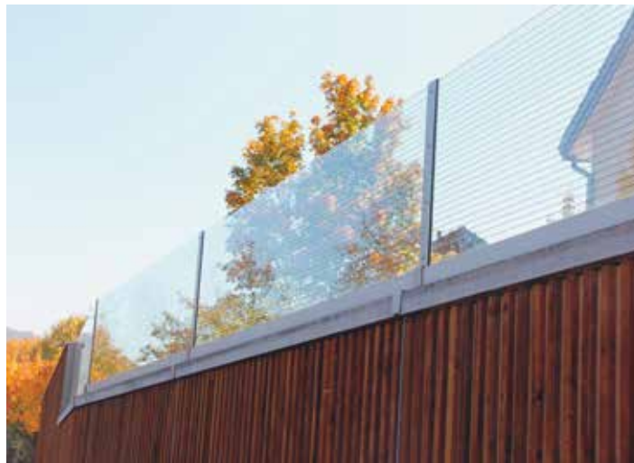
Bei der Holzlärm-schutzwand kam das System Vitrobar 20 zur Anwendung.
