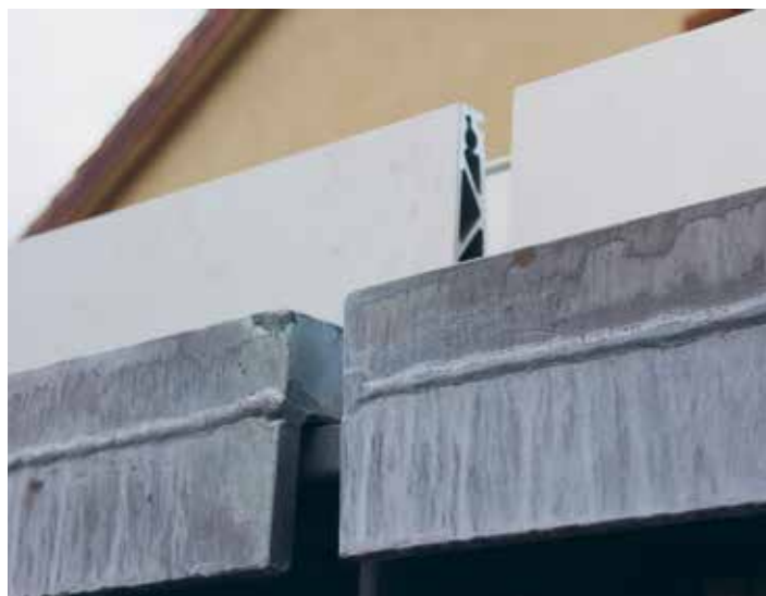
Auch der Profilstoss wird nach der Glasmontage mit speziellen Abdeckungen schallhemmend verschlossen.
