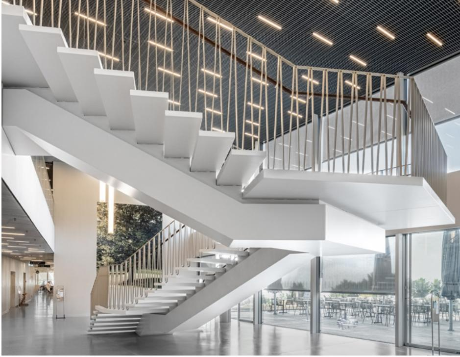
Der mehrdimensionale Tragholm wurde in drei Teilen angeliefert und am Bau zusammengefügt und verschweisst.
