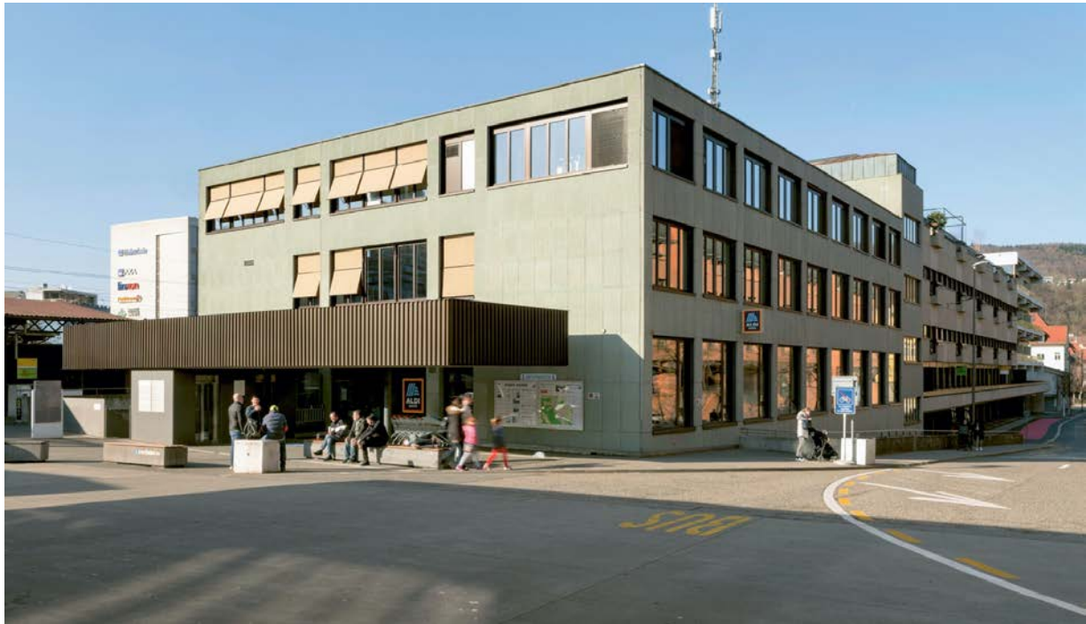
Das Vordach des Postgebäudes in Baden erhielt einen voluminösen Rand aus dunklem Trapezblech und bedrängt den Moser-Bau. (Foto: Susanne Stauss)
