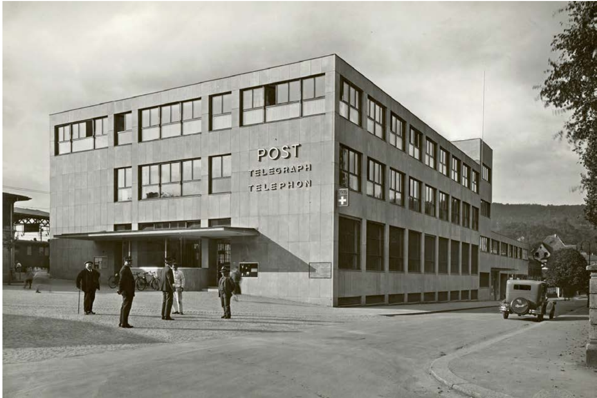
Die Post am Bahnhofplatz in Baden kurz nach der Fertigstellung. (Foto: H. Wolf-Bender Erben, GTA-Archiv, ETH Zürich)
